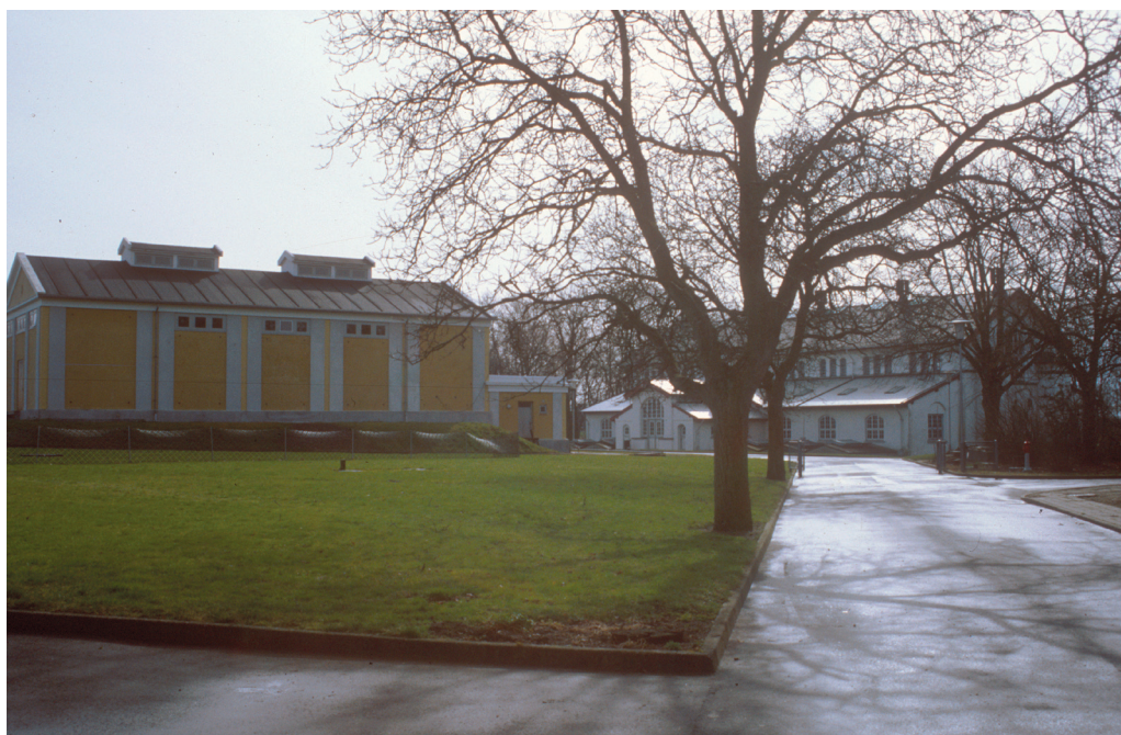
Thorsbro Vandværk marts 1992. Tv ses den klassicistiske filterbygning, der ikke er omfattet af fredningen. Fot.: Peter Sørenius.
