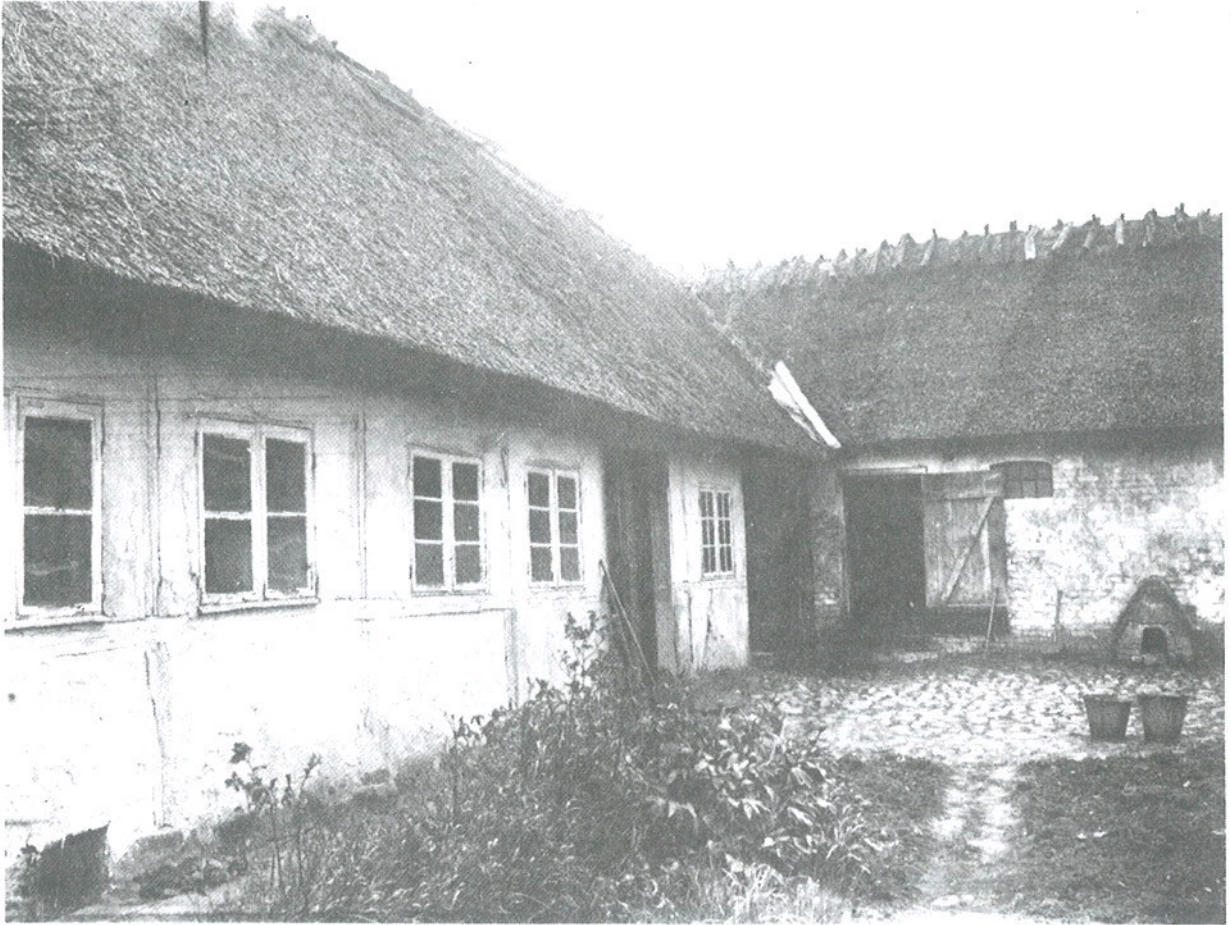
Sjællandsk bindingsværkshus med sidebåndkonstruktion Foto: G. Za Bøndergård
