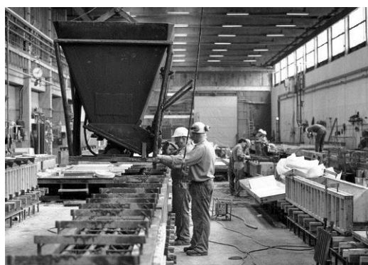
Der arbejdes på betonfabrikken Spæncom.
