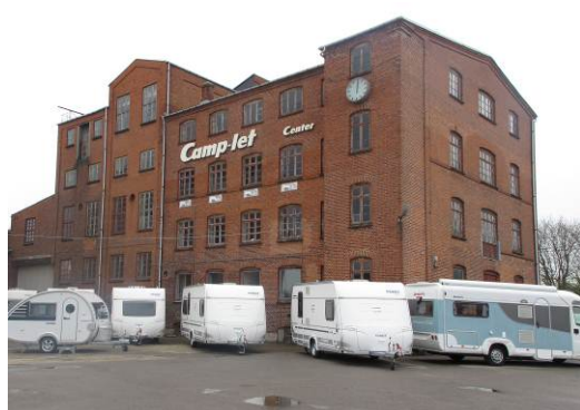
Kaffesurrogatfabrikken fra 1933 er et arkitektonisk eksempel på den vertikale industrielle produktion, der kommer til udtryk i den fuldmurede etagebygning.
