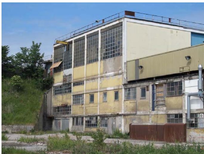
2012: Rockwools produktionsanlæg, der ligger i den tidligere Hedehusene grusgrav. Produktionen ophørte i 2002.
