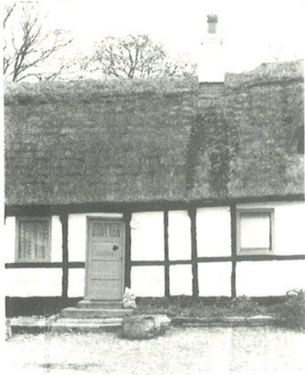
Stuehuset på Grønnbjerggård, Maglemosevej 1, har en skorsten med sokkel og udkrægning foroven. Den er idag forsynet med en keramisk pibe øverst.
