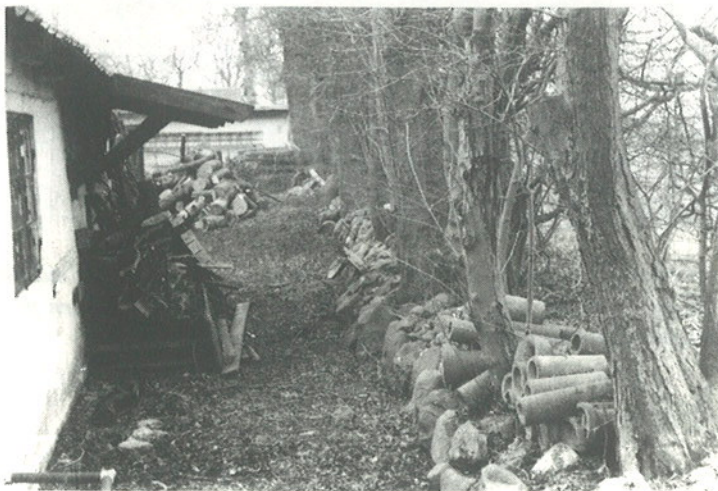
Et bevaret stengærde i skellet mellem marken og Smedevænget 32.
